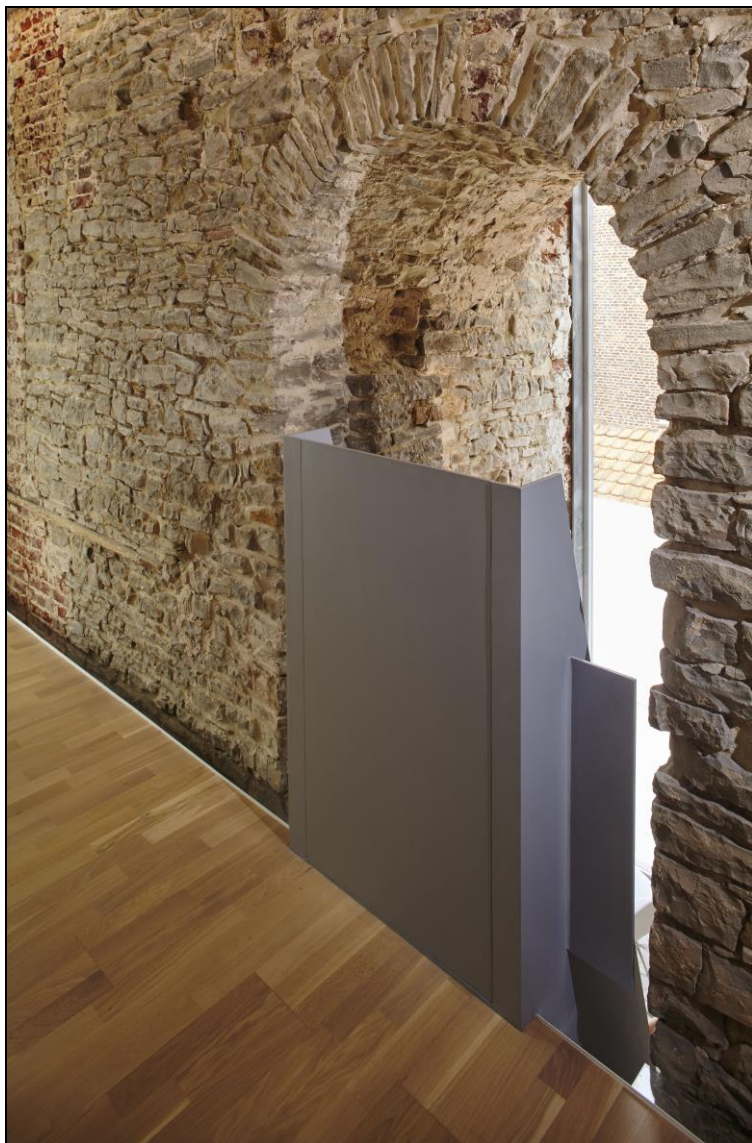
Foto van de hoofdtoegang met ontlastingsboog, opgebouwd uit spievormige en kleine veldstenen (© agentschap Onroerend Erfgoed, foto Kris Vandevorst).
