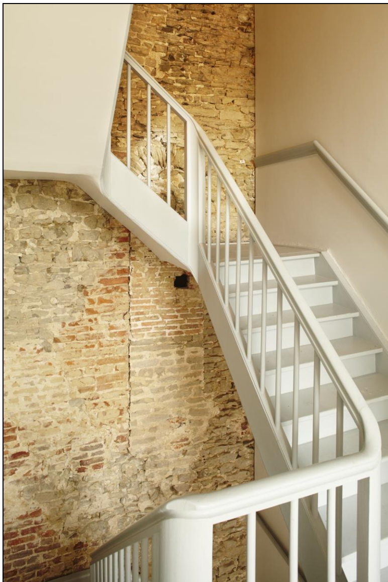
Bemerk de dichtgemaakte tweede toegang met ontlastingsboog achter de trap (© agentschap Onroerend Erfgoed, foto Kris Vandevorst).
