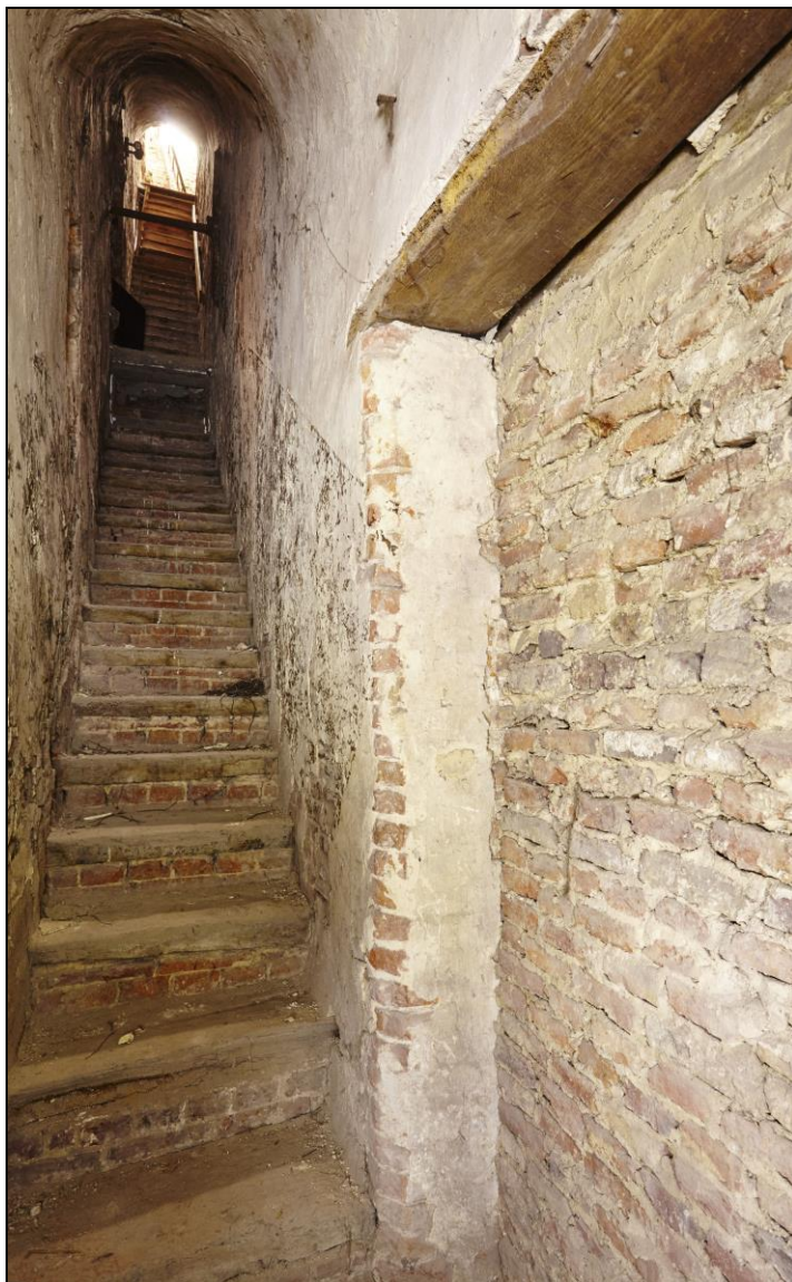
Foto van de steektrap in de dikte van de muur met rechts de dichtgemaakte toegang naar de eerste verdieping (© agentschap Onroerend Erfgoed, foto Kris Vandevorst).
